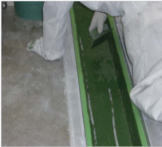
施工中状況 R付けにより排水がスムーズに行われ、水がたまりにくくなる。
