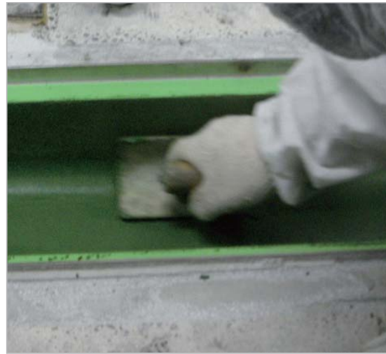
施工中状況 R付けにより排水がスムーズに行われ、水がたまりにくくなる。
