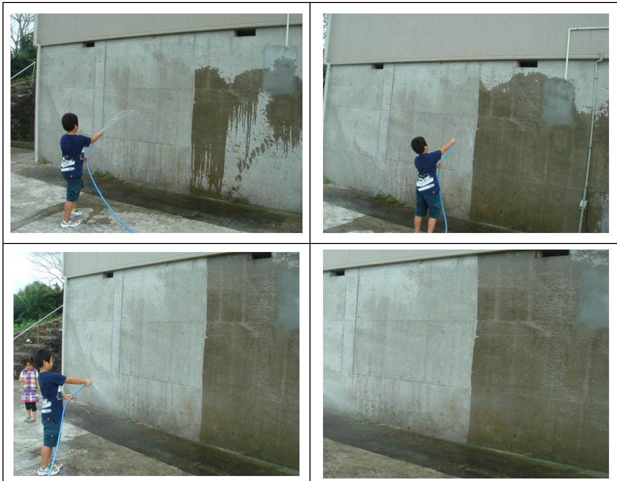
Sクリートガード塗布 未塗布
