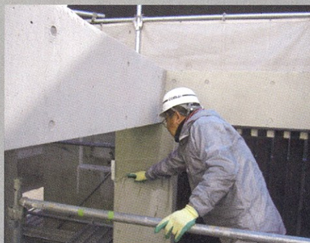
Sクリートガードを塗布。 SクリートガードとSクリートカラーは同じポリシロ キサン系のため塗材の相性が良く、Sクリートガー ドの撥水力が保持される。
