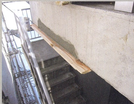
補修モルタルで再成形。
