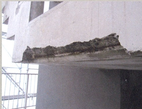
浮き部をはつり、鉄筋の防錆処理を施した後、Sク リートアップを塗布。Sクリートアップの効果により コンクリートの改質・緻密化、アルカリ性回復。また、 補修モルタルとの接着性が增强される。
